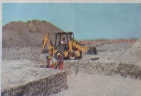
Trabajos avanzan aceleradamente.
