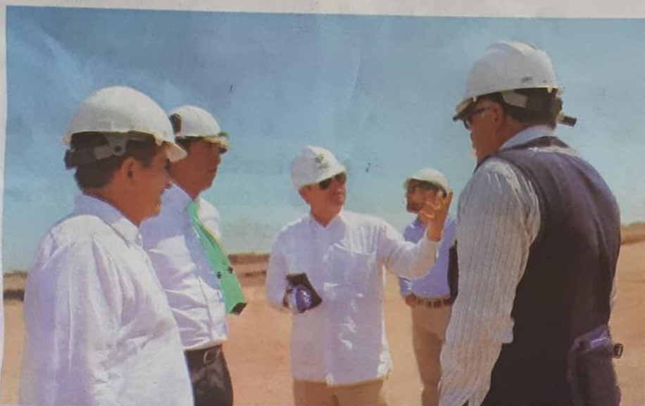
Embajador recorrió zona donde se construye Planta de Transferencia.
