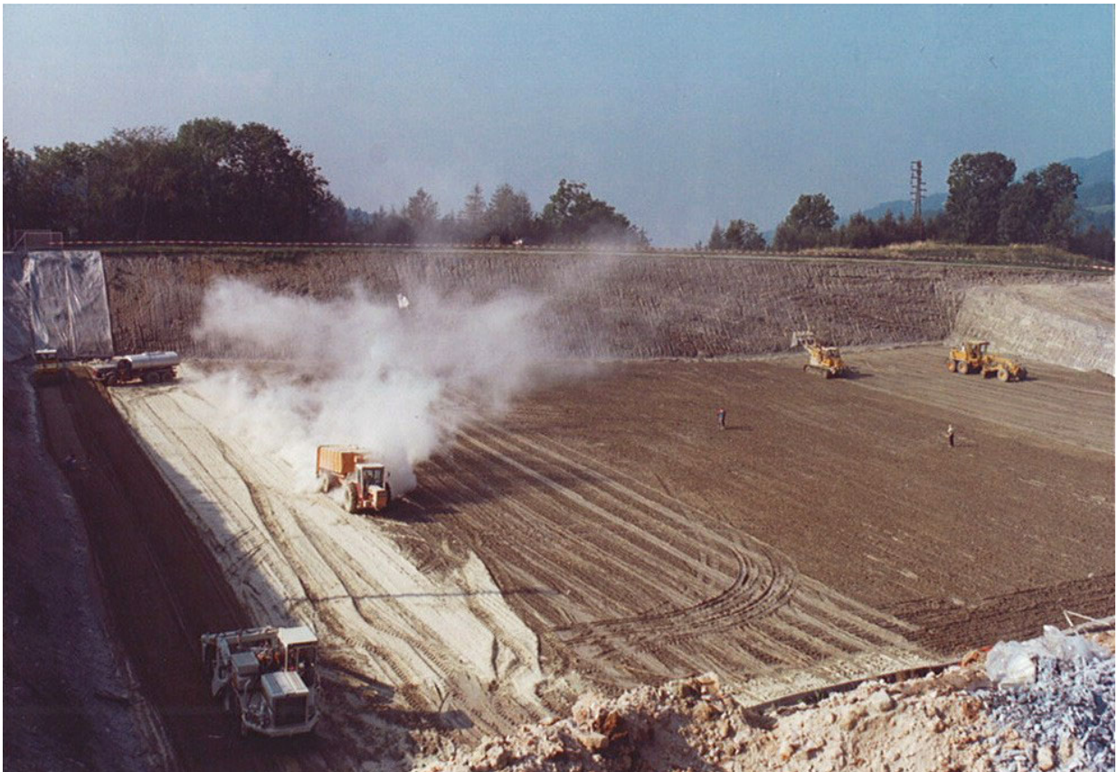
Foto 1: Proceso de impermeabilización - Relleno sanitario en Châtel-St-Denis - Suiza
