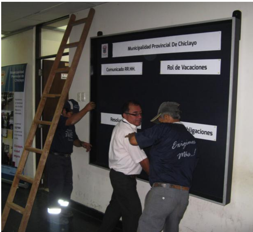
Foto 1: Instalación del Panel Informativo en la Sede Principal “Ex Mutual”
